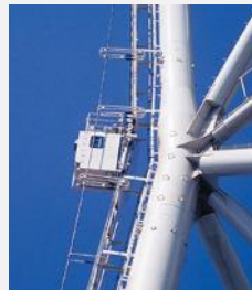
常設エレベーター
