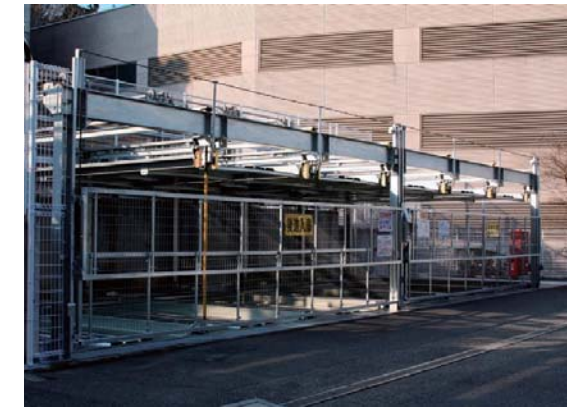
昇降横行式機械式駐車装置 「サノヤスパークP621型」 （高取台ロイヤルマンション）
