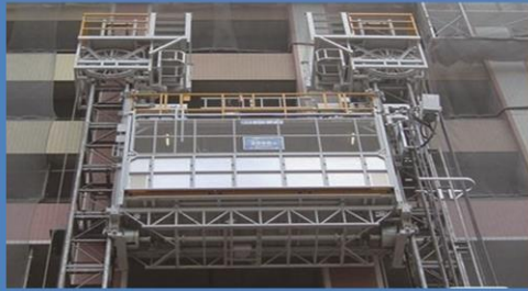
建設工事用エレベーター
