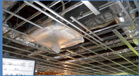
空調・給排水工事
