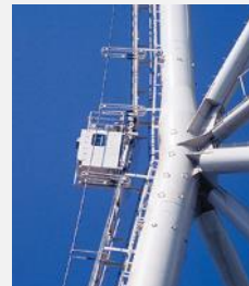
常設エレベーター
