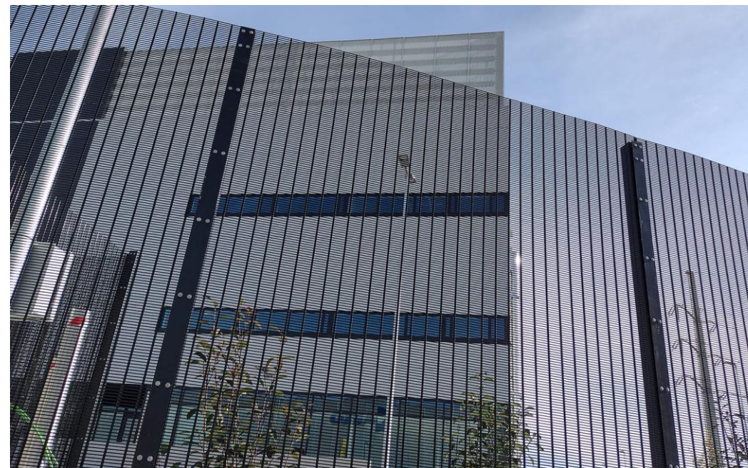
※この画像はメーカー商材写真であり、今回納品したデータセンターとは別の施設です。
