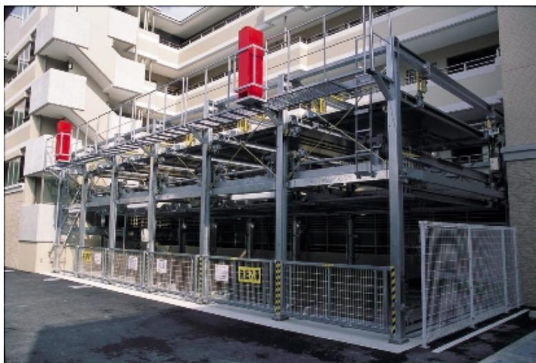
ピット昇降横行式駐車装置（地下2段・地上3段）
